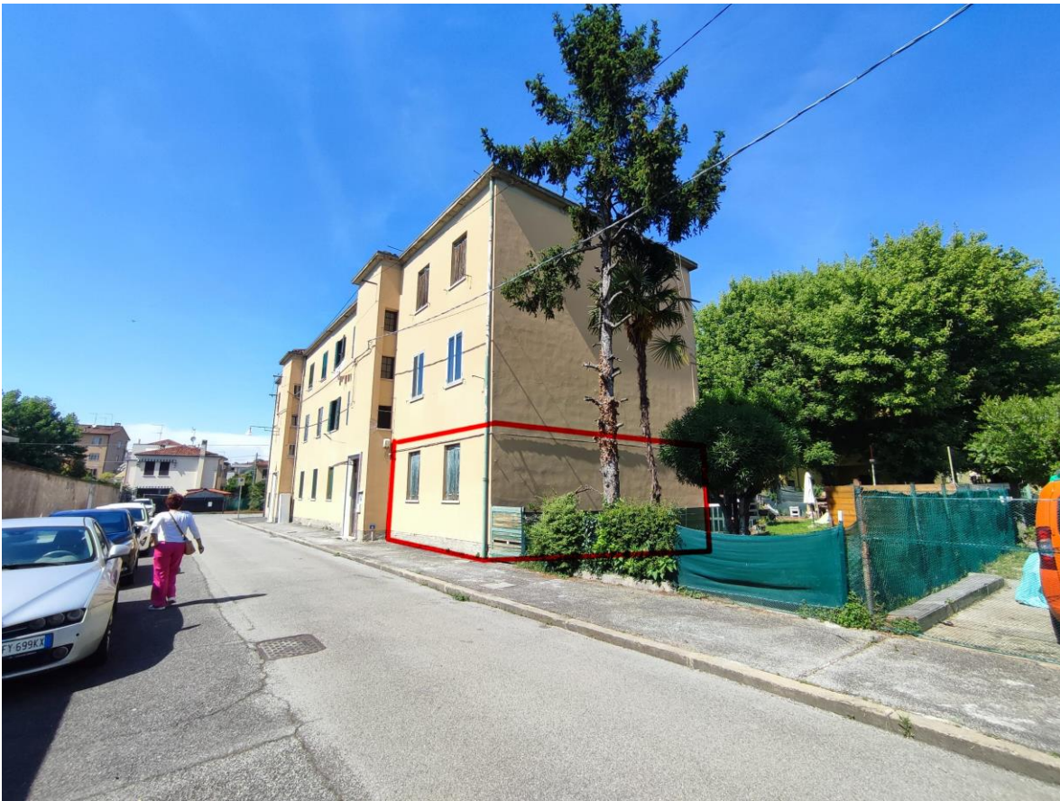
Vista immobile lato sud
