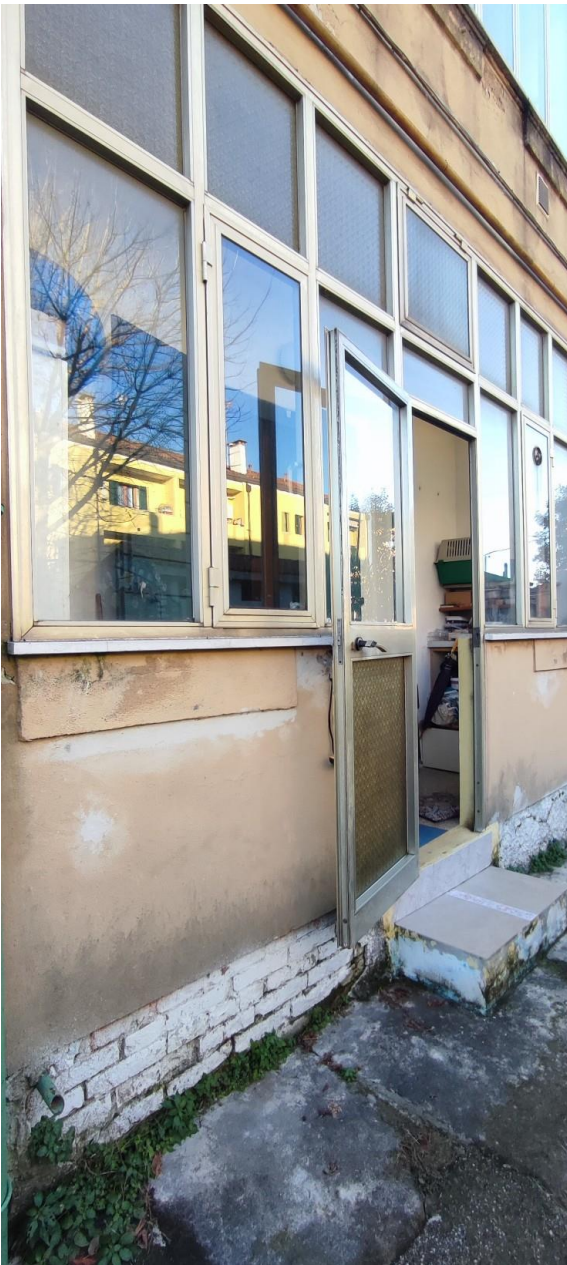
VERANDA VISTA DAL'ESTERNO
